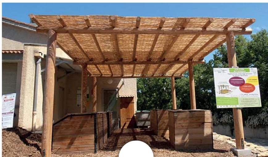
Compostage autonome en bacs Lycée Carnejane, Digne - 2013
