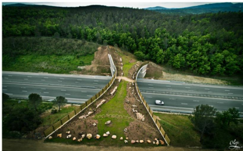
Vue générale de l'écopont de Brignoles avec la ligne intermittente des éco-restanques sur le côté gauche de l'ouvrage.
