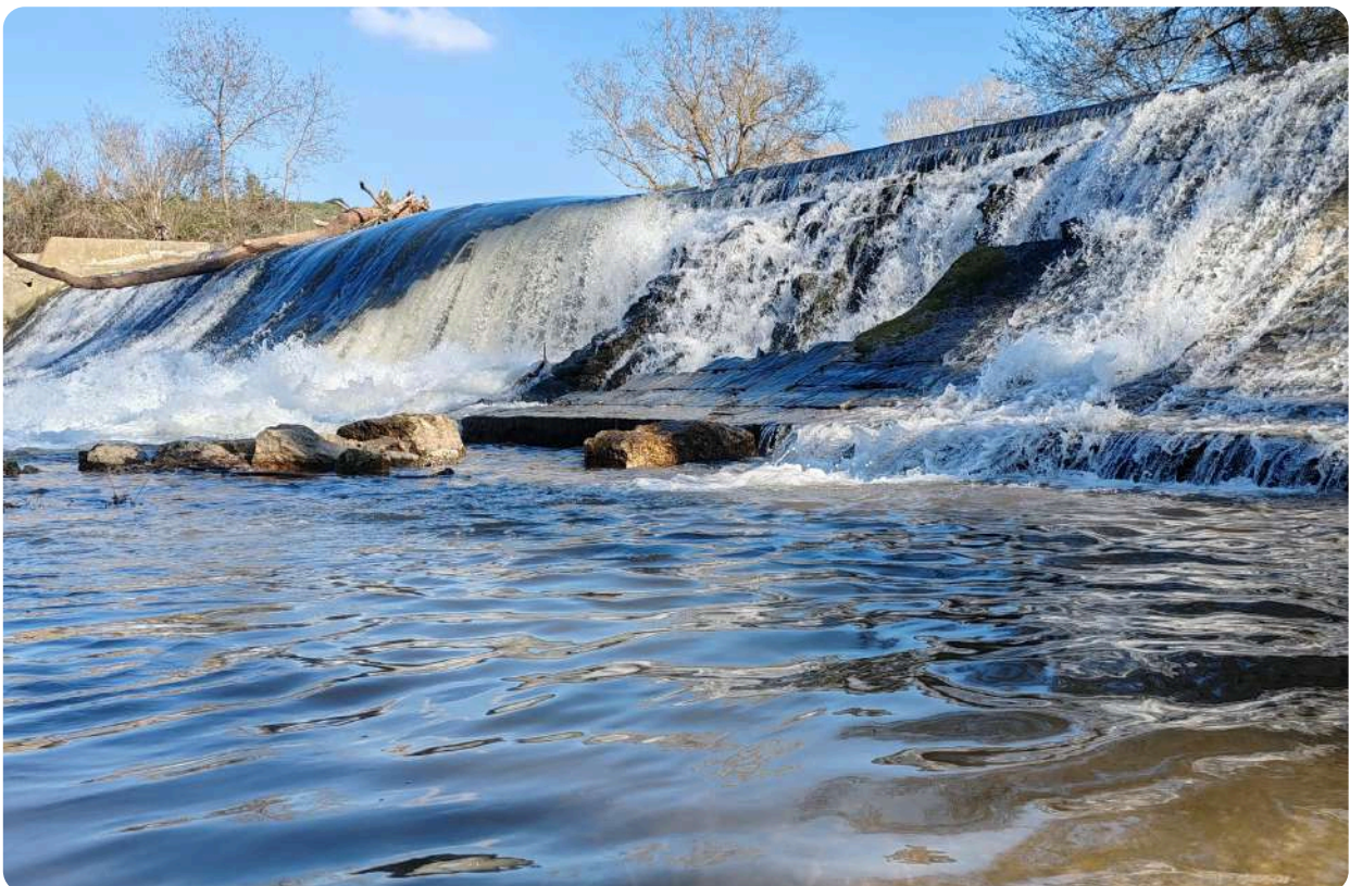
Le seuil de Roquefavour, à Ventabren (Bouches-du-Rhône), sera aménagé pour faciliter la circulation des anguilles d'Europe sur l'Arc. © Louane Aramand
