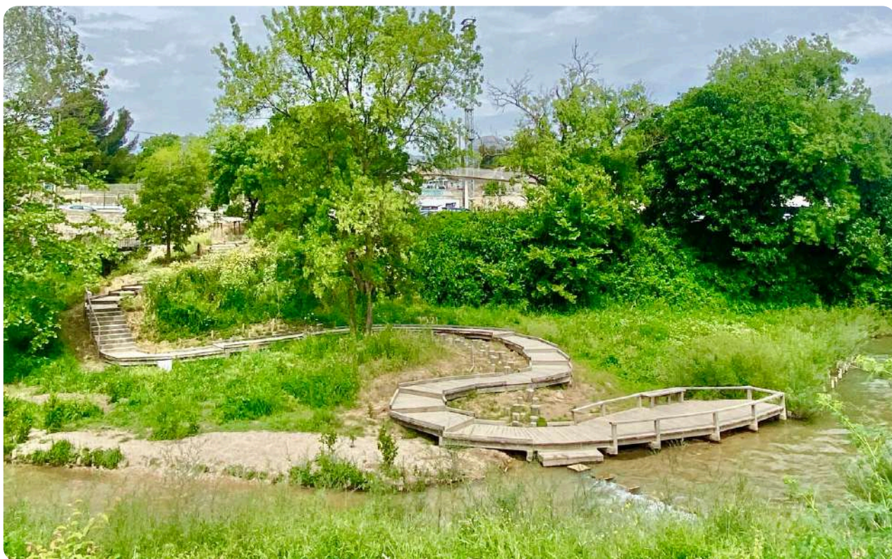
Après ajustements, le chantier a pu être mené à bien. © Gilles Zamo
